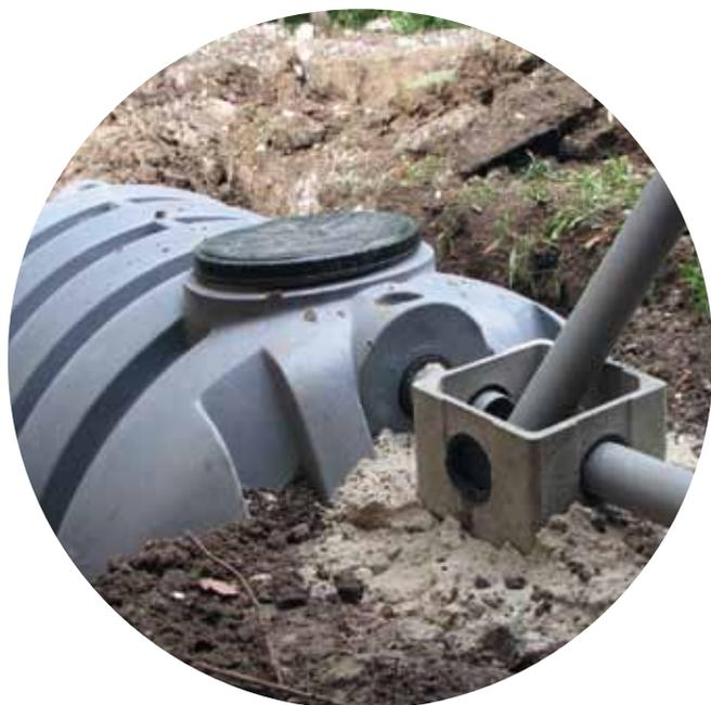
Installation d'une cuve enterrée. En raison du coût lié au terrassement, il est préférable de prévoir cet équipement lors de la construction, dans le cas d'une maison neuve.
