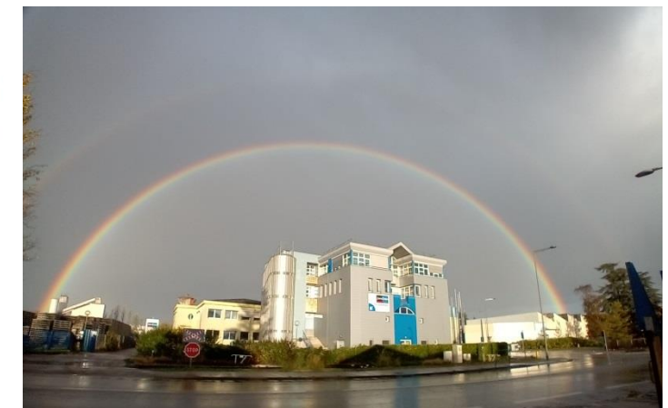
Parking privé + bâtiment Pôle Environnement
